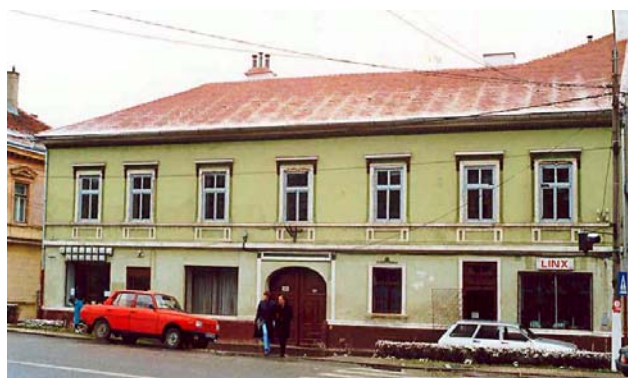
Die neuen gut isolierenden Fenster haben das Pfarrhaus wohnlicher gemacht. 2003 soll die Fassade renoviert werden.
