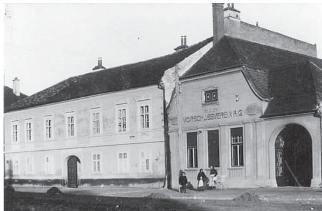
Das Pfarrhaus Anfang des 20. Jahrhunderts, rechts daneben das Gebäude des Zeidner Vorschussvereins, später Burzenländer Bürger- und Bauernbank, dann Entbindungsheim, heute Finanzamt
