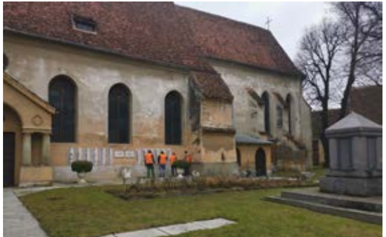
Die ersten Renovierungsarbeiten begannen noch vor Weihnachten ...
