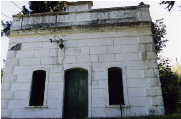
1906 wurde das Zeidner Wasserwerk „In den Woanerten“ erbaut. Hier ein Foto von D. Reimer von 2001.
