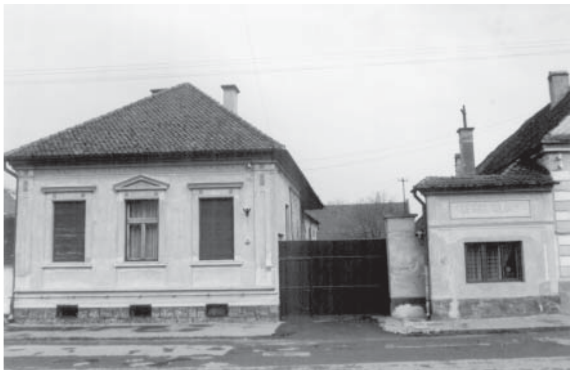
Hintergasse 84, rechts über dem Fenster steht „Georg Kloos“, alte Hausnr. 321
