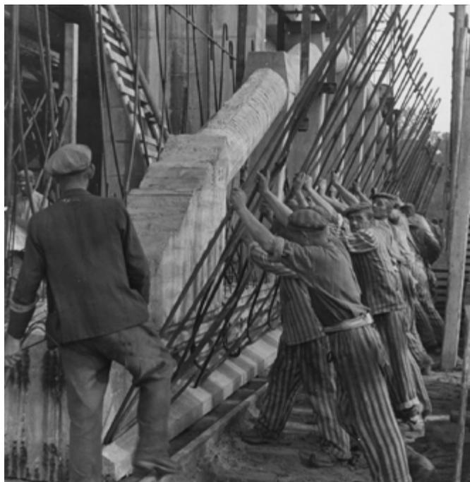
Zwangsarbeiter bei der Montage der Stahlbetonträger.
